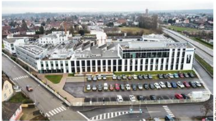
► Socomec a équipé son usine de Benfeld (67) de panneaux photovoltaïques et de bornes de recharge Hager.
