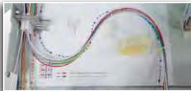
Un schéma de principe, collé sur le plateau, vous indique le chemin des fibres à respecter de votre câble entrant aux cassettes
